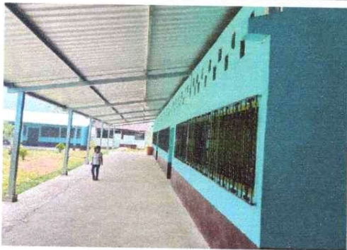
Foto 3: Instalación de estructura y lamina de aulas y aplicación de pintura finalizado.
