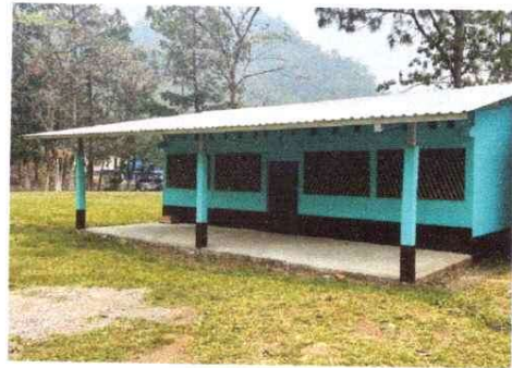
Foto 4: instalación de estructura y lamina de cocina y aplicación de pintura finalizado.
