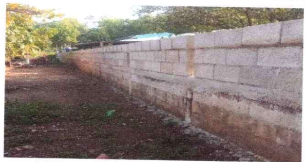
Foto 6: muro perimetral finalizado.
