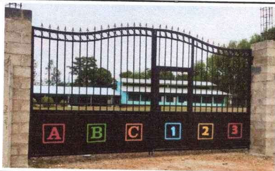
Foto 5: insalación de portón finalizado.
