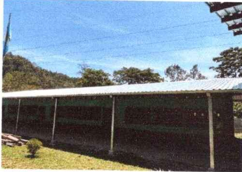
Foto1: sustitución de estructura y entechado de aulas finalizado.
